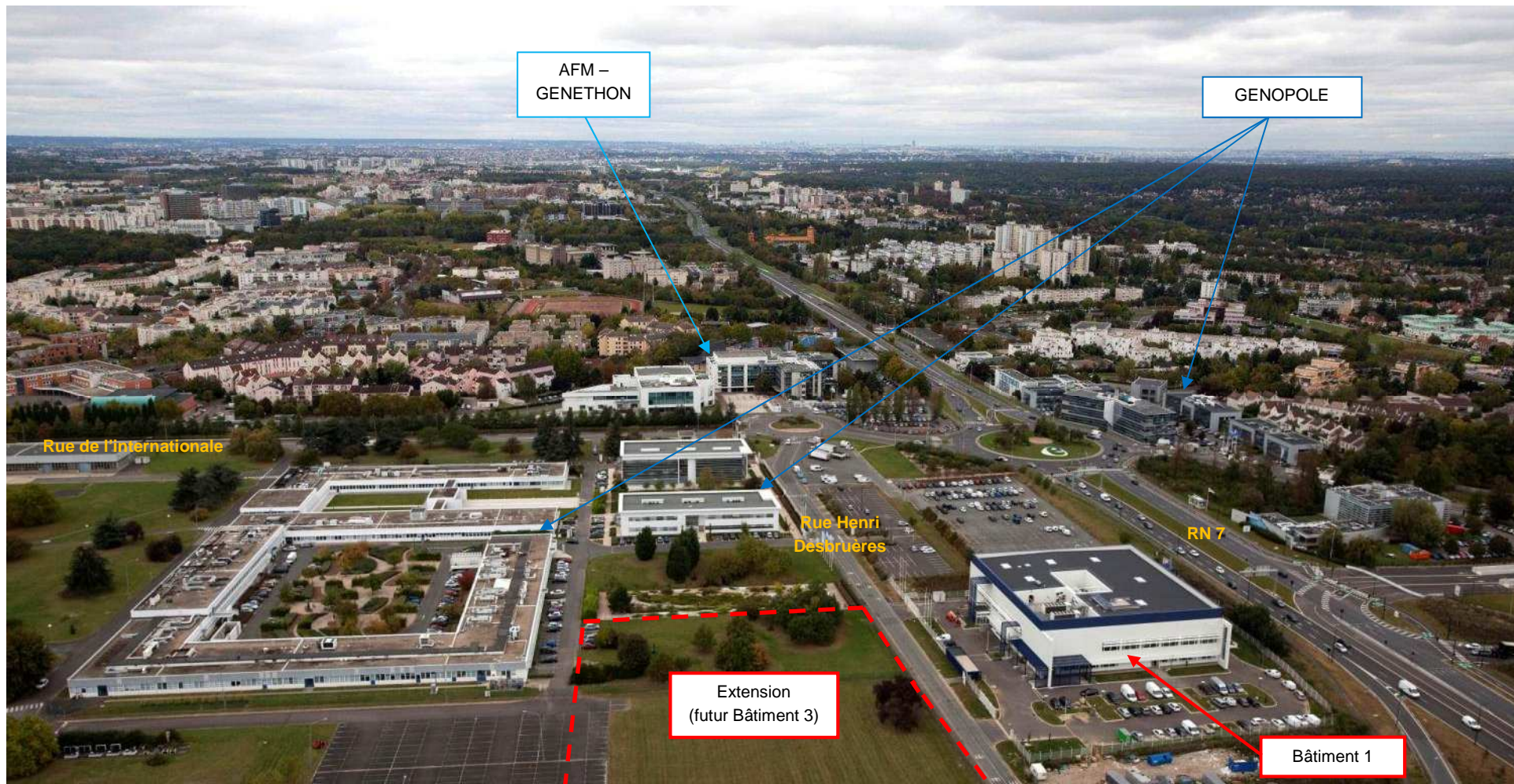
Figure 23 : Photo aérienne du Bâtiment 1
