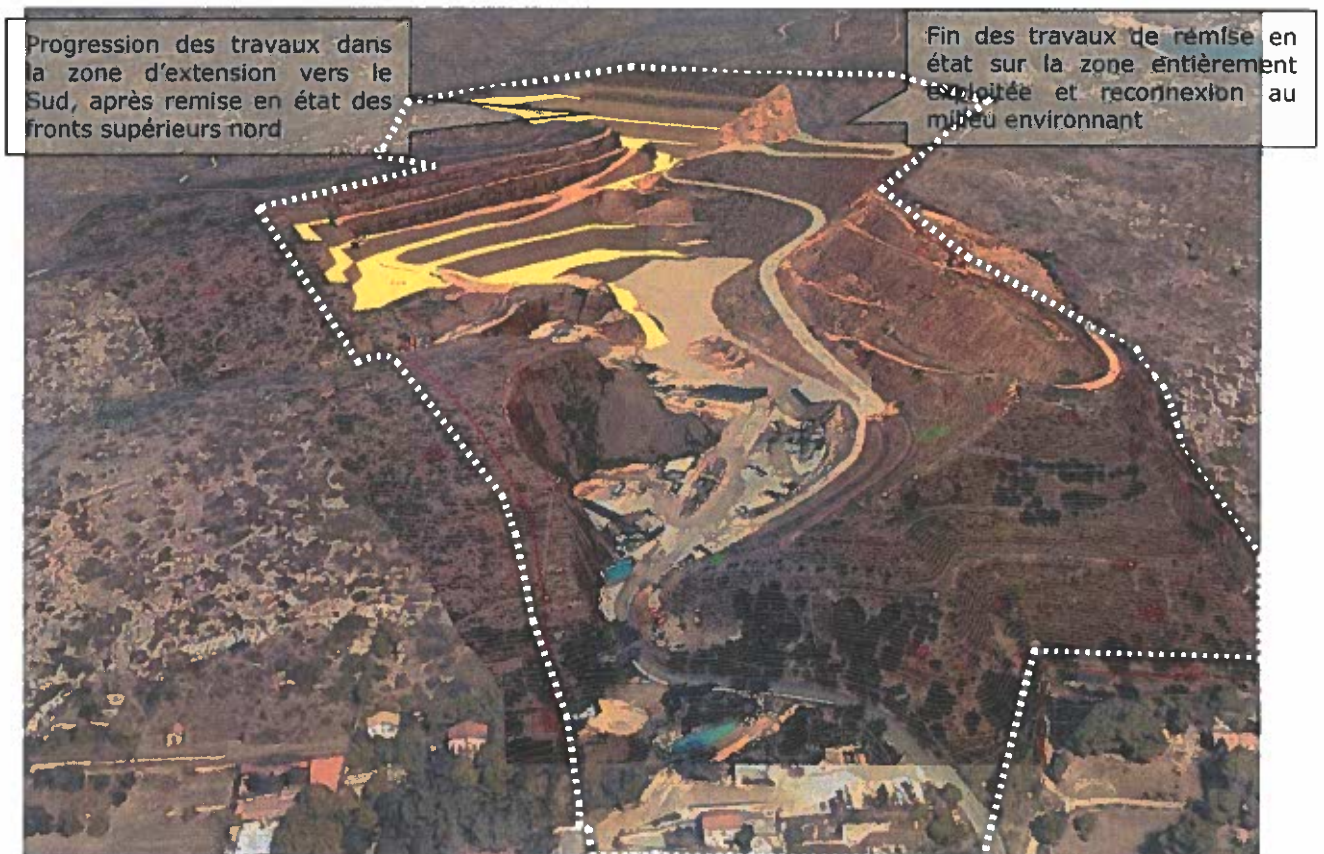
Extension des travaux de la Phase 2
