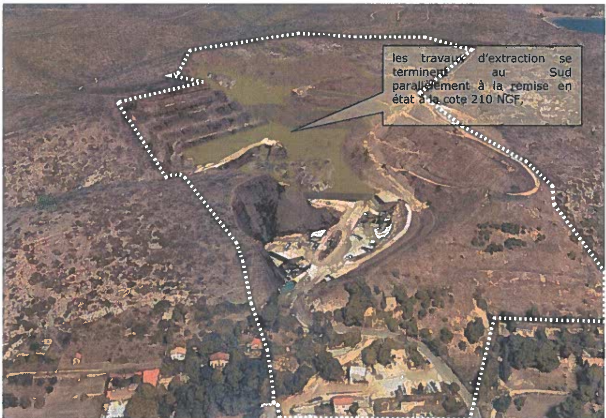
Extension des travaux de la Phase 6
