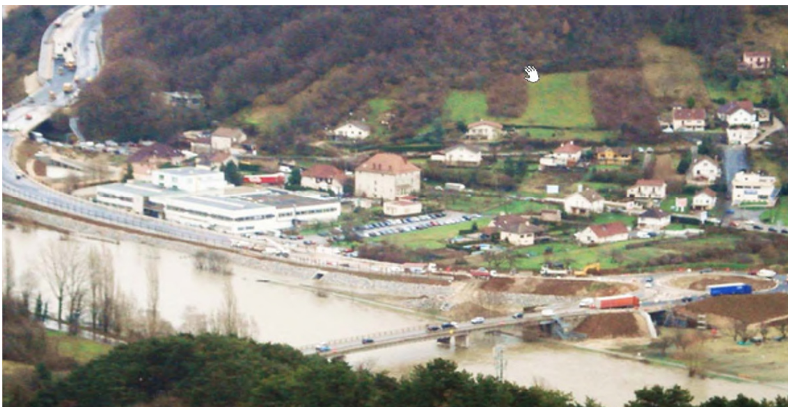
Figure 15 : Vue du remblai des Mercureaux pendant les travaux (source DREAL)
