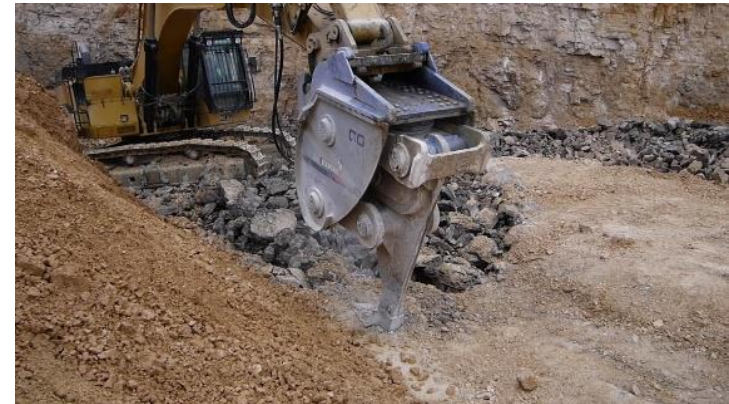
Dent de déroctage vibrante utilisée pour l'abattage des matériaux
