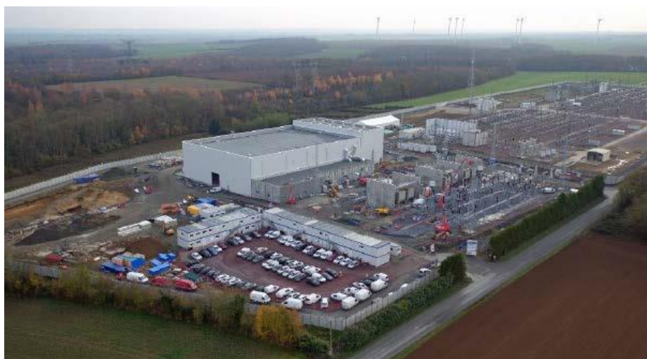
Figure 2 : Exemple de station de conversion existante (source : dossier)
